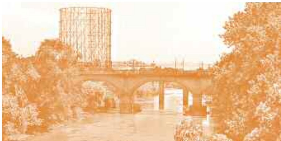
Ponte ferroviario di San Paolo, Roma, 1910
